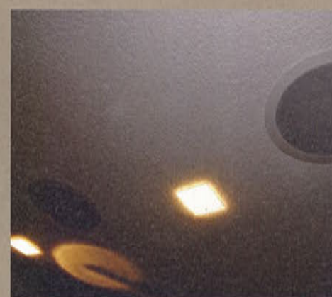
Altoparlanti impermeabili ad acqua e vapore
