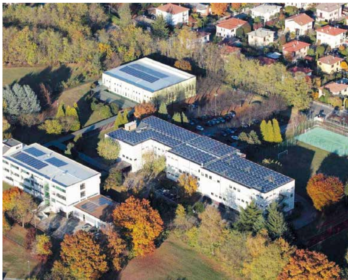
Impianto Fotovoltaico 178,02kWp installato sul tetto dell'Istituto Superiore Carlo Alberto Dalla Chiesa di Sesto Calende_VA
