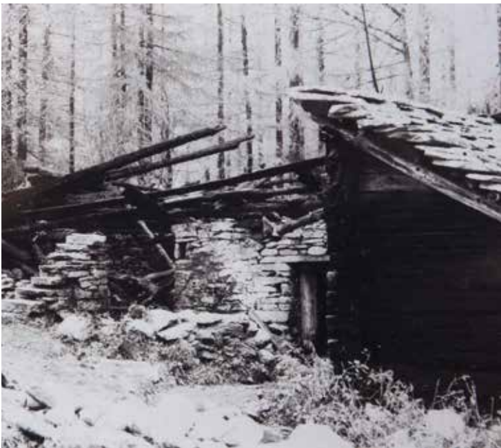
L'esterno in abete rosso, l'interno in larice con un'intercapedine di 4 cm di sughero per isolarsi dal freddo.
