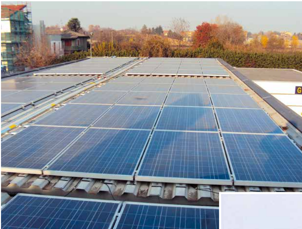
Impianto fotovoltaico 17,86kWp installato sulla pensilina del distributore Q8 di LIMBIATE_MI
